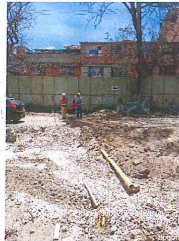
Instalación de nueva tubería para agua residual. Fecha: 23-08-2023.
