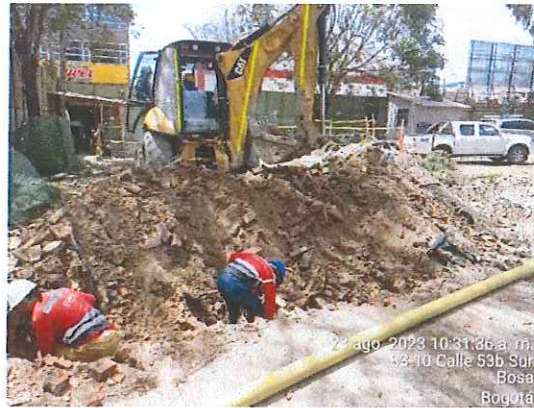
Instalación de nueva tubería para agua residual. Fecha: 23-08-2023.
